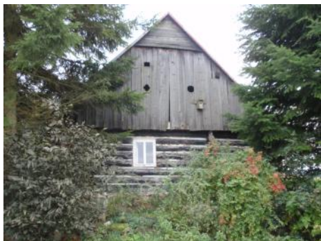
Roubené stavení ve Staré Pasečnici
